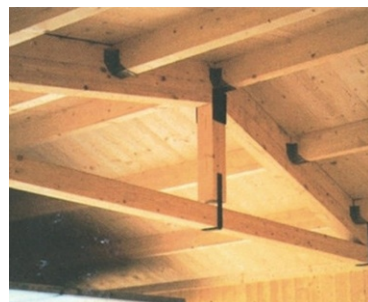
Capriata in legno lamellare con vista sottotetto
