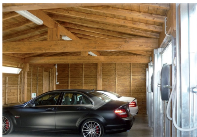
Capriata in legno lamellare con vista sottotetto
