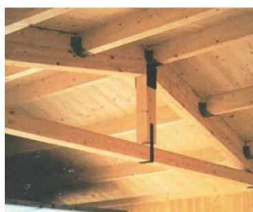
Capriata in legno lamellare con vista sottotetto
