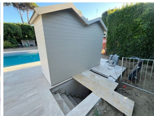
2 Cabine mare a batteria
