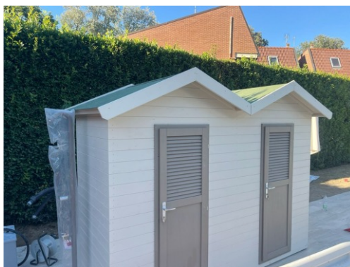
2 Cabine mare a batteria
