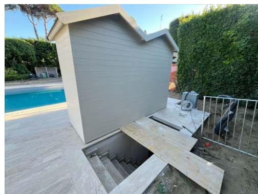
2 Cabine mare a batteria
