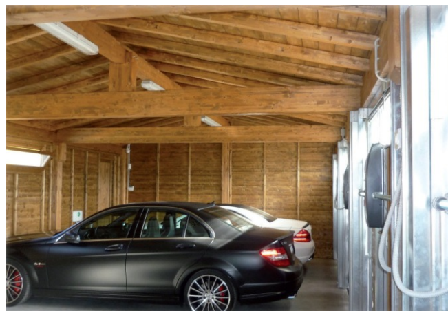
Capriata in legno lamellare con vista sottotetto
