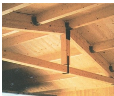
Capriata in legno lamellare con vista sottotetto
