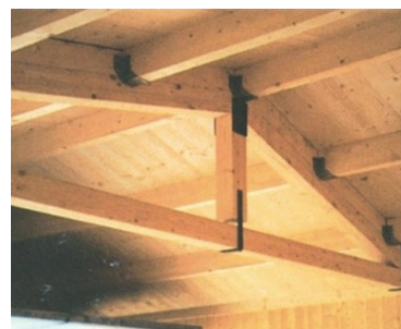
Capriata in legno lamellare con vista sottotetto
